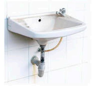
Figura 10.4 Los sanitarios escolares deben recibir mantenimiento constante para evitar deterioros y fugas.
